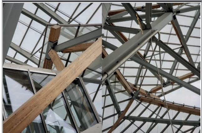
FIGURA 3. EMPLEO DEL GLULAM EN LA ESTRUCTURA INTERNA DEL EDIFICIO DE LA FUNDACIÓN LOUIS VUITTON (LV), EN PARÍS, FRANCIA
